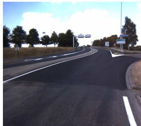
Figure 6 – Coefficient de luminance rétro-réfléchi mesuré avec l'appareil ECODYN le long d'une section de route de 3,5 km dotée d'un revêtement en béton bitumineux (à proximité de Strasbourg). La photographie à droite montre le changement de revêtement qui explique la rupture de R_L à partir de l'abscisse 1 500 m.
